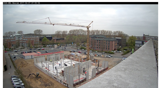
Abbildung 2 Baufortschritt am 07. April 2017
