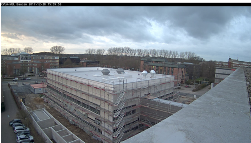
Abbildung 4 Baufortschritt am 28. Dezember 2017
